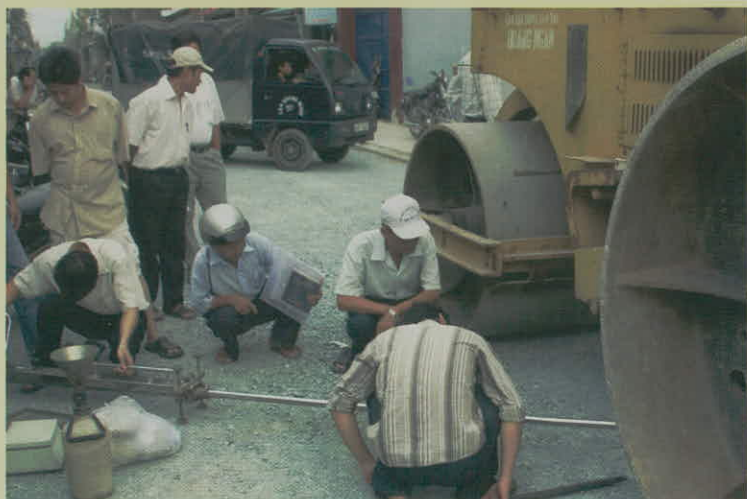
Nhân dân tham gia giám sát sửa chữa đường
